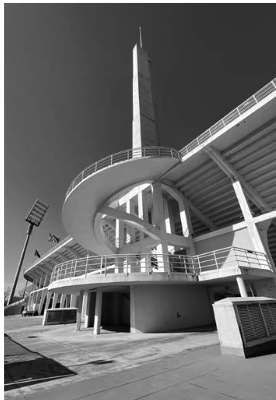
Fig. 19 – Vista esterna della Torre di Maratona e delle scale elicoidali (03/2021).
